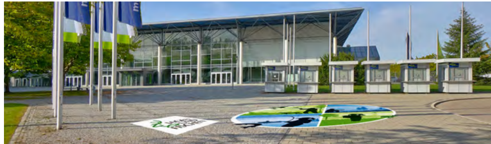
Abb. 1 – Floor Prints im Außenbereich
